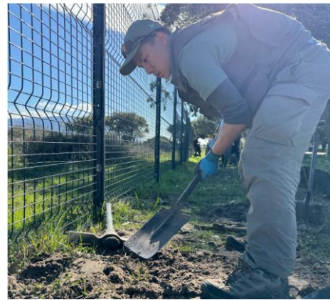
圖五、為自然保育區建造生態廊道
